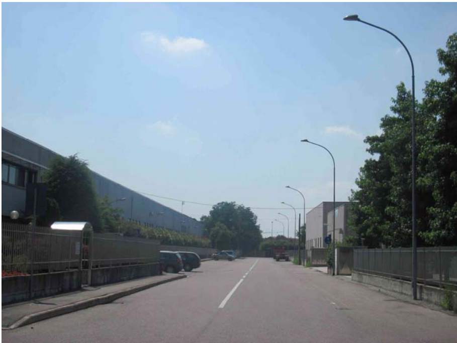
Via del Tornago: esempio di nuovo impianto costituito da pali in c.a.c. con apparecchi stradali totalmente schermati dotati di lampade ai vapori di sodio ad alta pressione ed installati su palo in acciaio zincato, con linea di alimentazione interrata.
