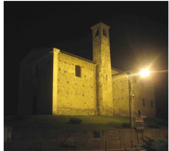
Abbazia di S. Maria in Monticello: percezione fotografica notturna del prospetto sud
