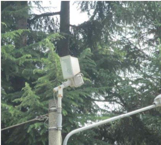
Proiettore per l'illuminazione d'accento dell'Abbazia di S. Maria in Monticello
