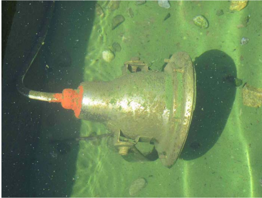
Proiettore subacqueo per l'illuminazione d'accento della Fontana di Via Boccaccio
