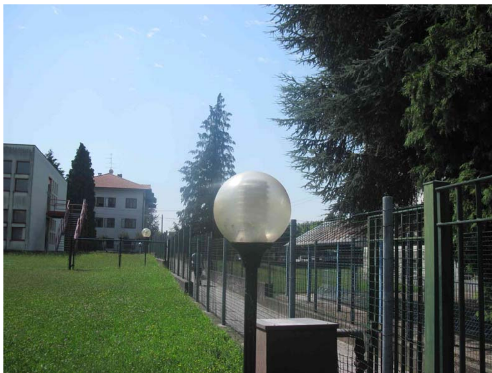
Area verde di competenza della palestra e della scuola elementare: apparecchi di tipo decorativo diffondenti non conformi alle leggi regionali vigenti.
