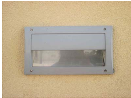
Centro Concordia: incassi a terra diffondenti e incassi a parete totalmente schermati dotati di lampade fluorescenti compatte, conformi alla L.R. 17/2000 e s.m.i.
