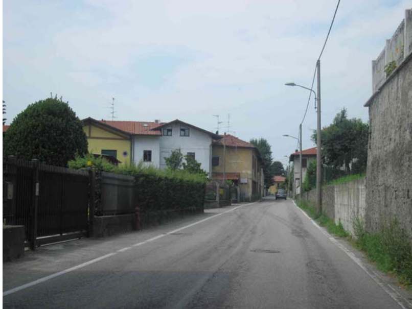
Via D'Annunzio: esempio di impianto esistente costituito da pali in c.a.c. con linea di alimentazione aerea dove le vecchie armature prive di vetro di chiusura ed equipaggiate con sorgenti obsolete ai vapori di mercurio sono state sostituite da apparecchi stradali totalmente schermati dotati di lampade ai vapori di sodio ad alta pressione.
