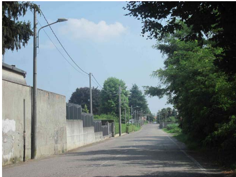
Via Novara: esempio di impianto esistente costituito da pali in c.a.c. con linea di alimentazione aerea dove gli apparecchi privi di vetro di chiusura dotati di lampade ai vapori di mercurio sono stati sostituiti da armature stradali totalmente schermate equipaggiate con sorgenti ai vapori di sodio ad alta pressione.
