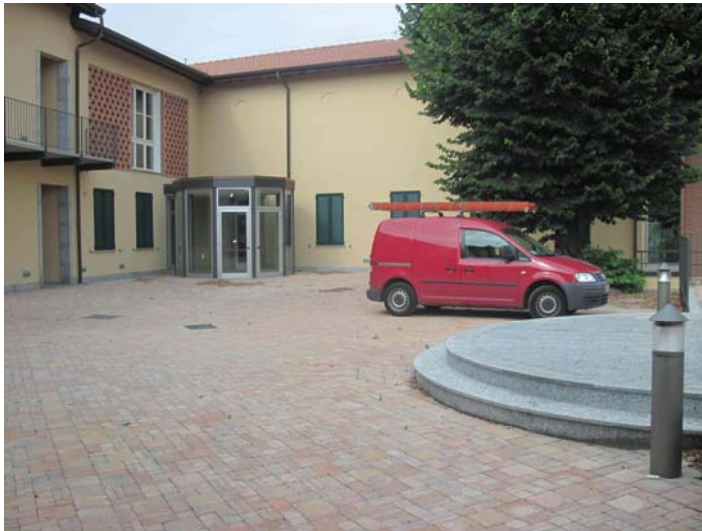
Parcheggio Centro Concordia: paletti segnaletici decorativi totalmente schermati equipaggiati con sorgenti fluorescenti compatte conformi alle leggi regionali vigenti.
