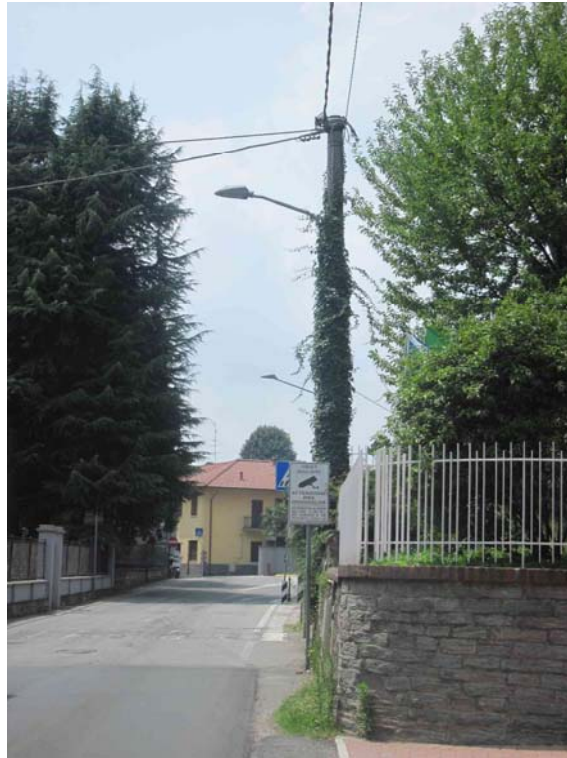
Via D'Annunzio: palo in c.a.c. ricoperto da vegetazione infestante
