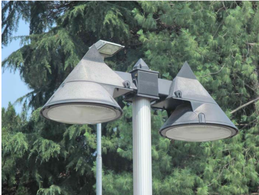
Piazza XXV Aprile: apparecchi decorativi totalmente schermati conformi alla L.R. 17/2000 e s.m.i.
