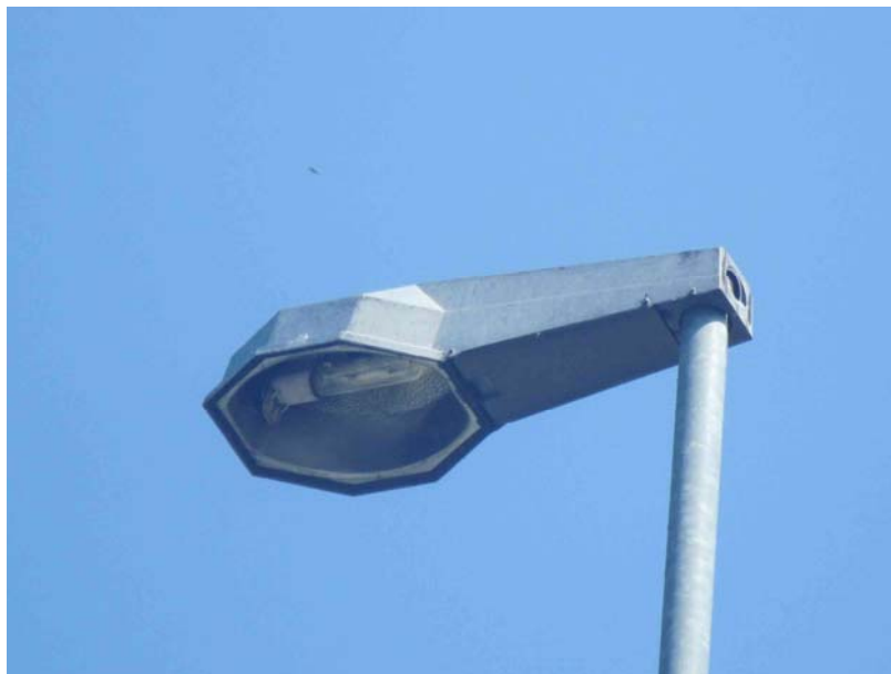
Via D'Annunzio: armatura stradale priva di vetro di chiusura, non conforme alle leggi regionali vigenti
