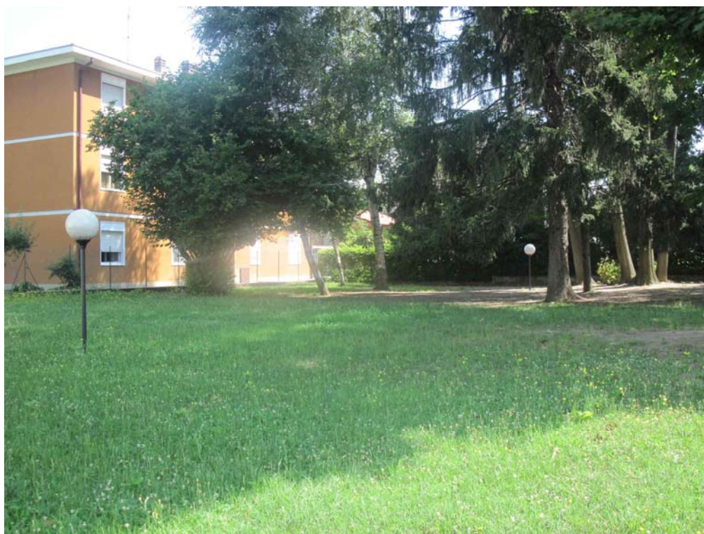
Area verde di competenza della palestra e della scuola elementare: apparecchi di tipo decorativo diffondenti non conformi alle leggi regionali vigenti.
